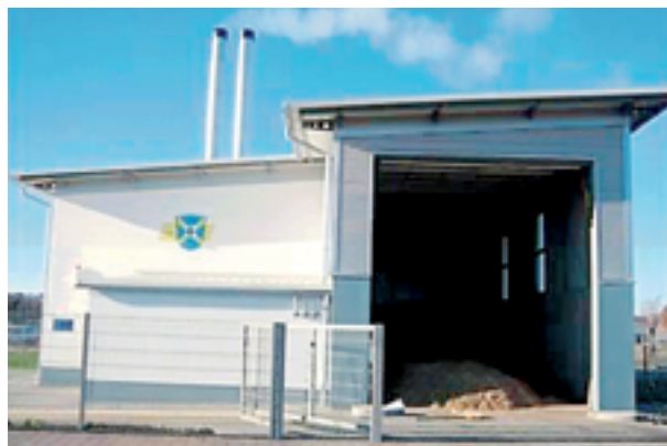
Slika 3.9: Nadzemni, natkriveni silos za drvnu sečku sa prilazom na prizemnom nivou /hessenENERGIE 2012/
