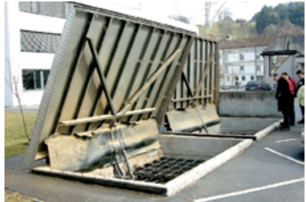
Slika 3.11: Podzemni dubinski silos /hessenENERGIE 2012/
