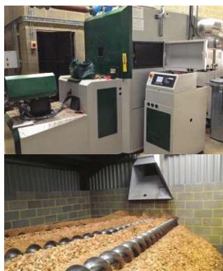
Kotlarnica i spremište goriva
