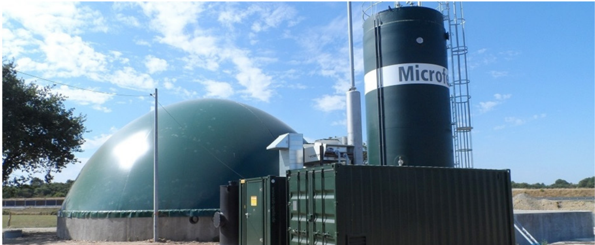
Slika 2. Biogasno postrojenje sa fermentorom, dozatorom za tečnu fazu, toplotnim kontejnerom i CHP-om (proizvodnja električne i toplotne energije)
