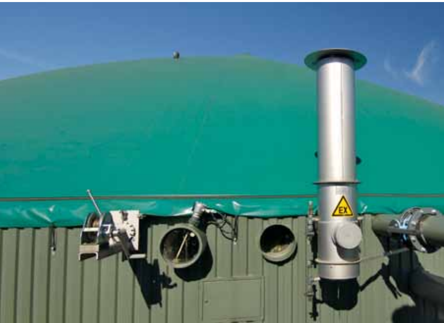
Uređaj za zaštitu od previsokog i preniskog pritiska na digestoru
