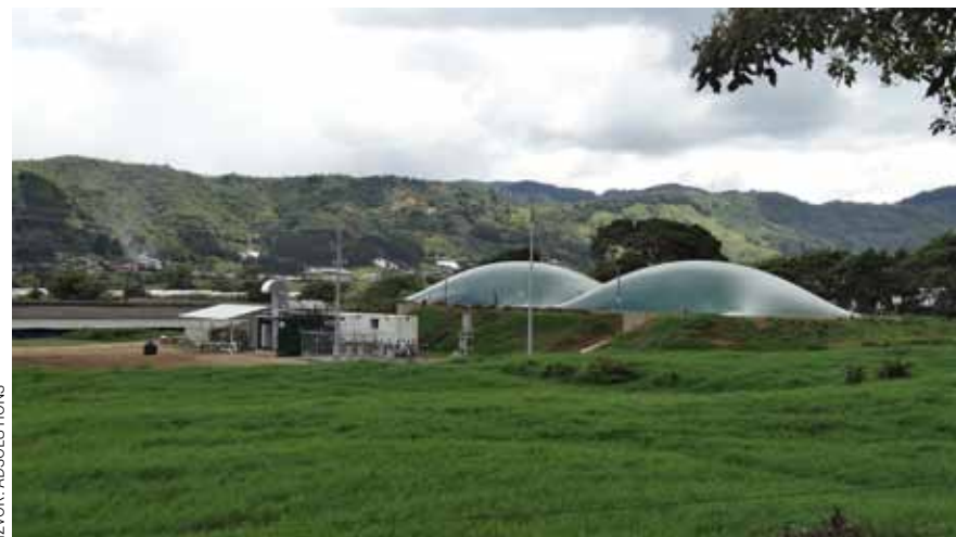
Digester u obliku lagune u Kostariki
